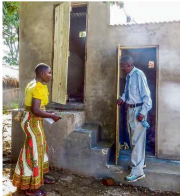
So sehen die EcoSan-Sanitärhäuser aus. Auf dem Treppenpodest ist die Toilette, darunter werden die Fäkalien kompostiert. Hinter der rechten Tür befindet sich eine Dusche. Ganz rechts, hier nicht zu sehen, ist noch ein außen angebrachtes Handwaschbecken. Die Frau und der Mann vor dem Sanitärhaus sind die Eigentümer.
