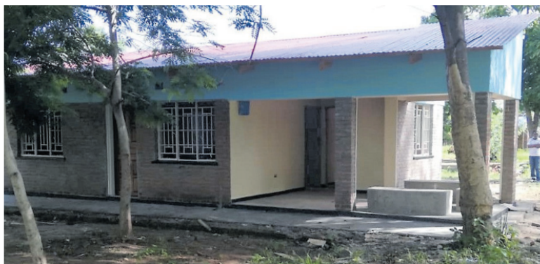
Die Village Clinic in Chilumba hat zwei Behandlungsräume. Die Terrasse dient als Wartezimmer.
