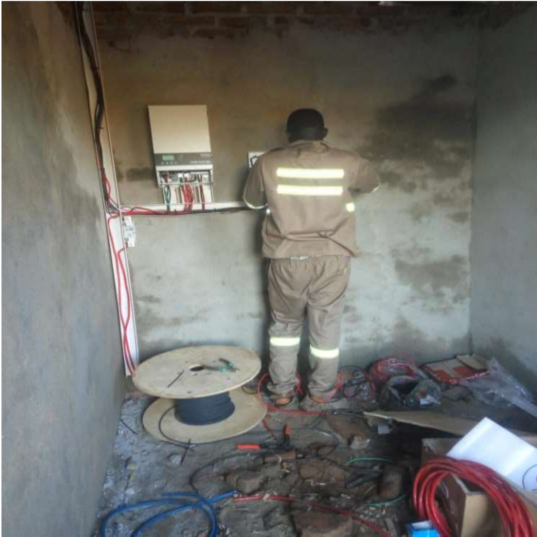
Teamplanet-Mitarbeiter bei Installationsarbeiten Nähwerkstätte
